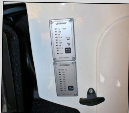
Afin de garder un œil sur la batterie au lithium cachée sous le plancher ainsi que sur le niveau restant dans le réservoir d'eau, ces deux indicateurs Votronic se révèlent bien pratiques.
